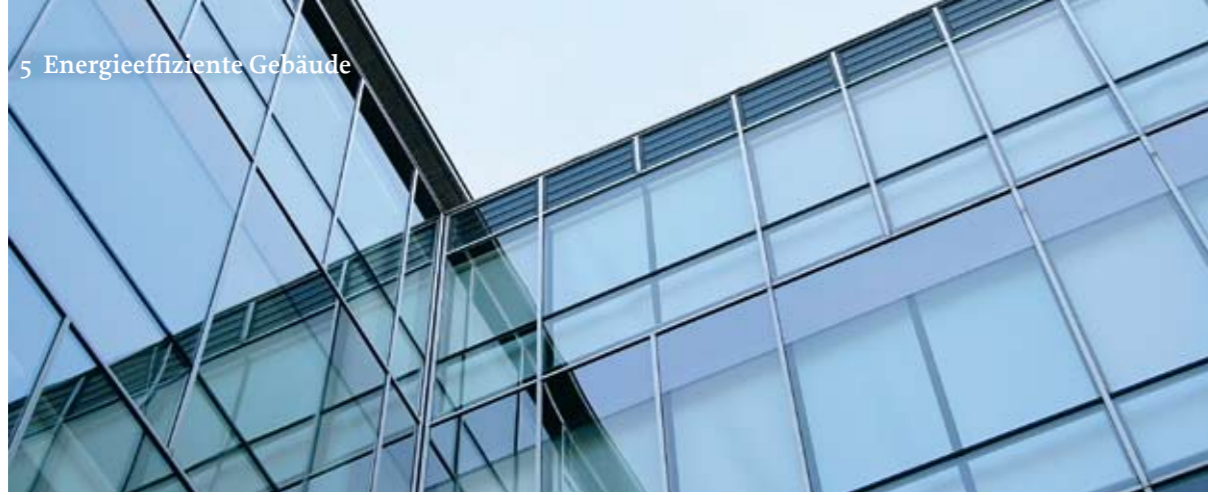
Die richtige Fassadentechnik zahlt sich durch weniger Energieverlust schnell aus.
